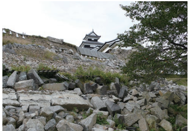
東日本大震災により旧小峰城の石積みが崩落
