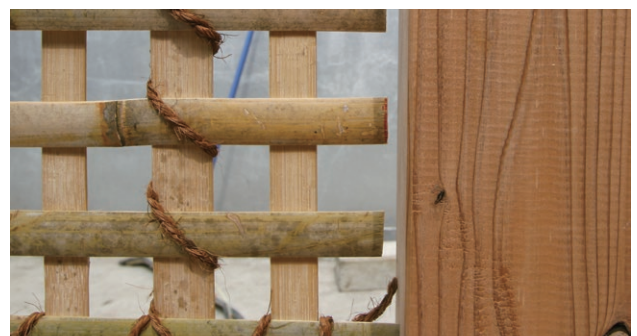
小舞竹の間隔や、軸組との隙間
