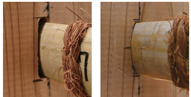
軸組への小舞下地の取り付け方法
