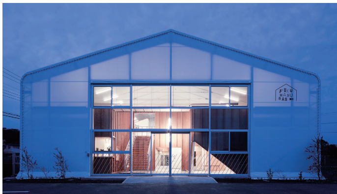
フクマススペース／福増幼稚園新館
